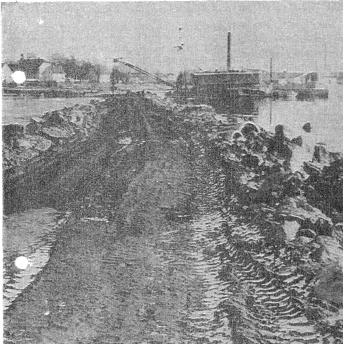
Fra mudringsarbeidene i Vallø bukten. Mudderapparatet på bildet har hovedentreprenør Karsten Abrahamsen engasjert av firma A/S Hoyer Ellefsen.
